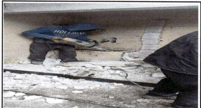
**Foto 2:** trabajadores Destruyendo piso de baño, para la Sustitución de piso cerámico.
