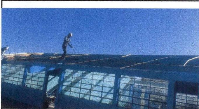
**Foto 1:** Durante la Sustitución de lámina por lámina troquelada aluzinc calibre 26, Sustitución de capote de lámina para lámina troquelada calibre 26 y Sustitución de elementos de fijación desmontando la lámina.
