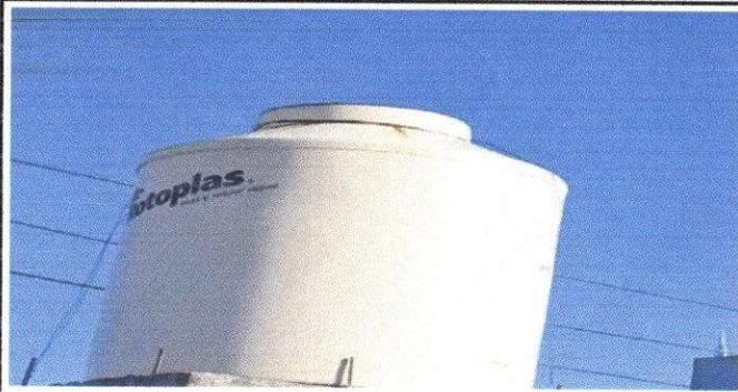
Foto 7: Estado del tinaco para la Sustitución de depósito de agua 1100 lt
