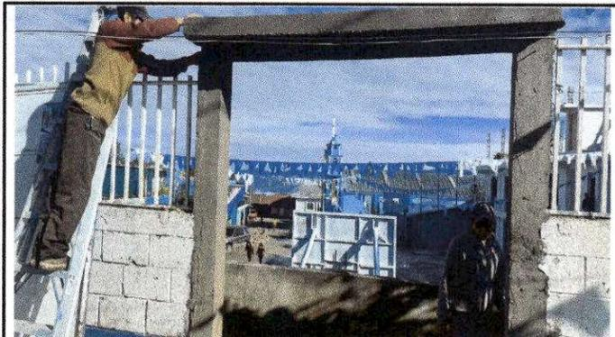
**Foto 3:** Fundición de columnas de sostén de portón, para el Mantenimiento a portones de metal
