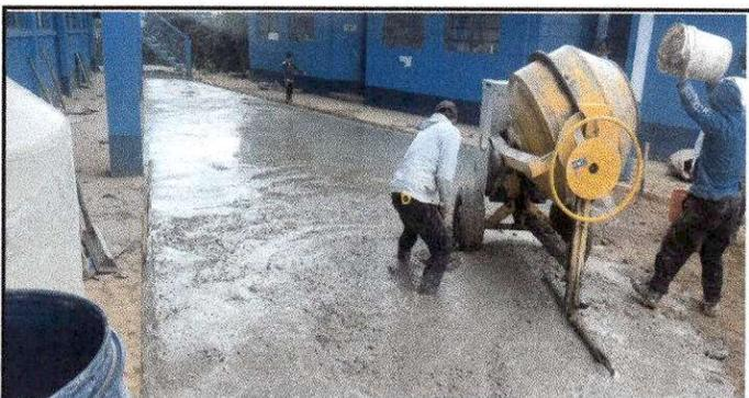
**Foto 5:** Fundición de piso, para la reparación de planchas de concreto de patio
